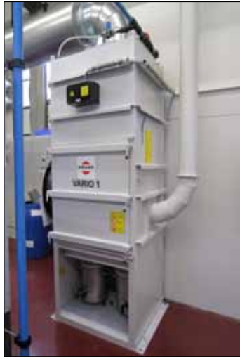
VARIO 1 eco als Zentrale Vakuum-Saug-anlage
